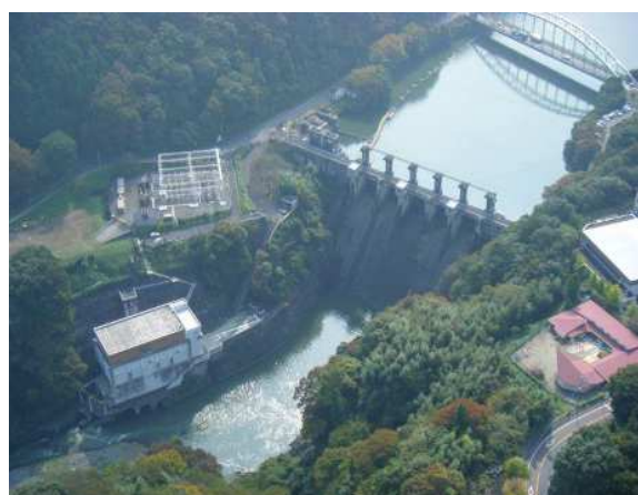
相模ダムと相模発電所
