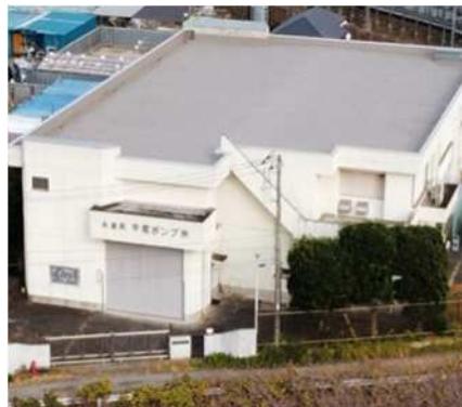
平塚揚水ポンプ所
