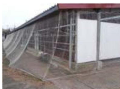
防鳥ネットの補修
