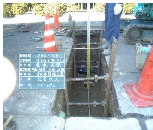
⑥ 配管状況
