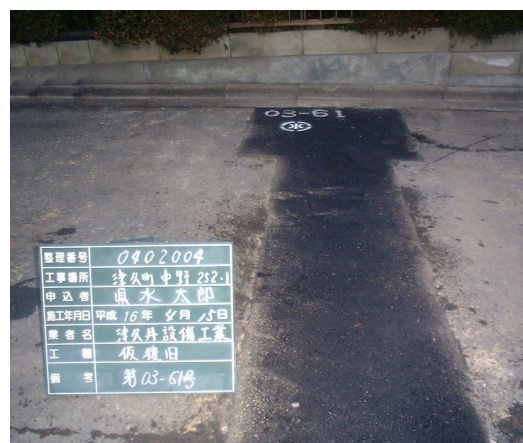
⑫ 仮復旧工 ④マーク及び掘削占用許可番号の表示、周囲の路面状況が分かるように撮影する
