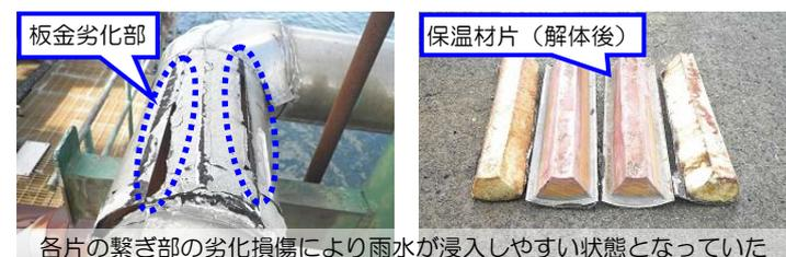
↑図6 配管サポート部は板金や保温材の劣化は見られなかったものの、当該ノズル部にはスチームトレースが巻かれており、局部的に加温されることにより温度範囲が変化して腐食が進行したものと考えられる。
