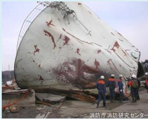
津波によるタンクの転倒※2
