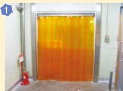
虫が好む波長の光を遮断するカーテンを張り、外部から虫を呼び寄せないようにします。虫的好む波長を出さない蛍光灯を設置する工場もあります。
