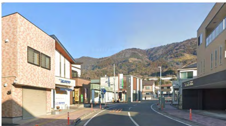
電線地中化工事（松田町内）
