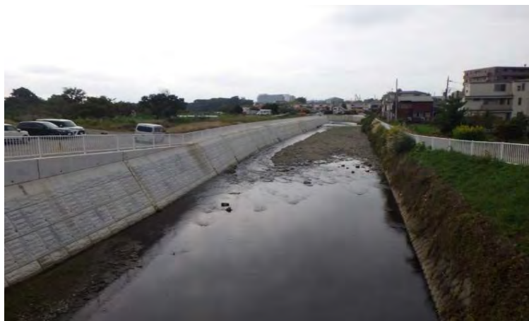
護岸整備工事（引地川（藤沢市内））
