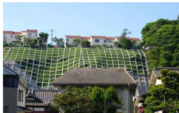
急傾斜地崩壊対策（横浜市中区内）
