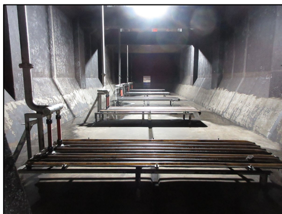
散気装置の改築更新（相模川流域下水道右岸処理場）
