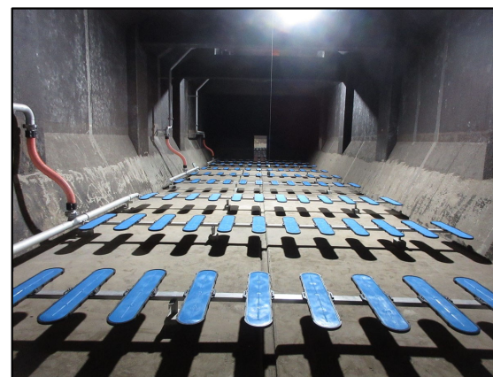
散気装置の改築更新（相模川流域下水道右岸処理場）
