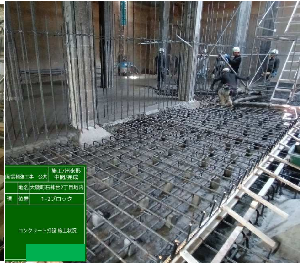
耐震性を向上させるため配水池内部の底板を厚くしている様子
