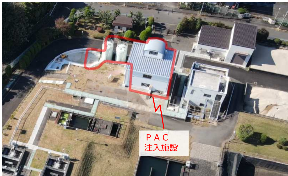
PAC注入施設
