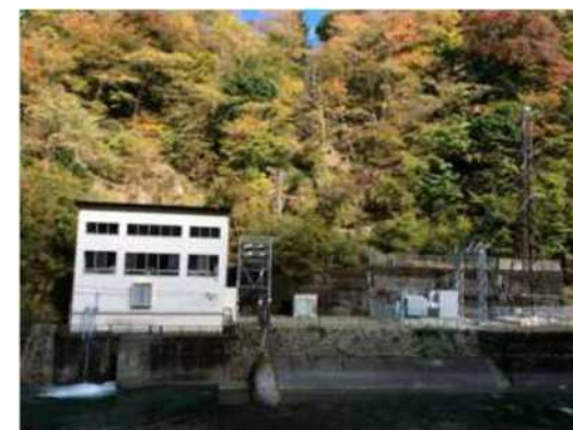
玄倉第2発電所
