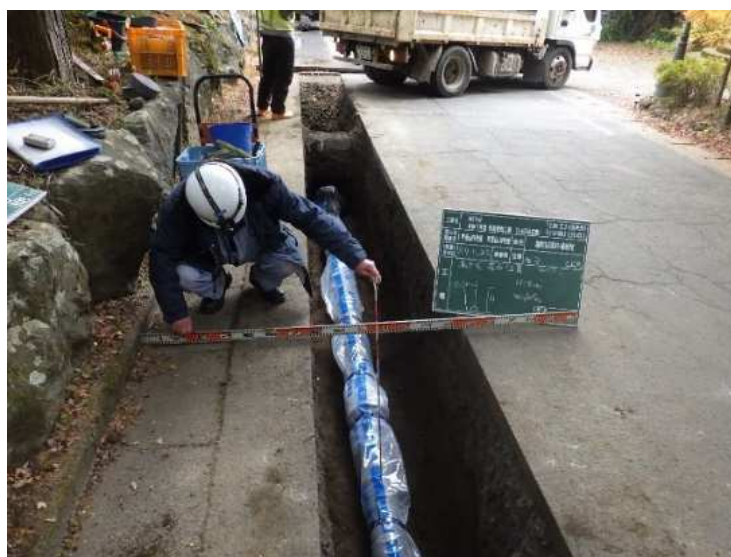
管路工事写真
