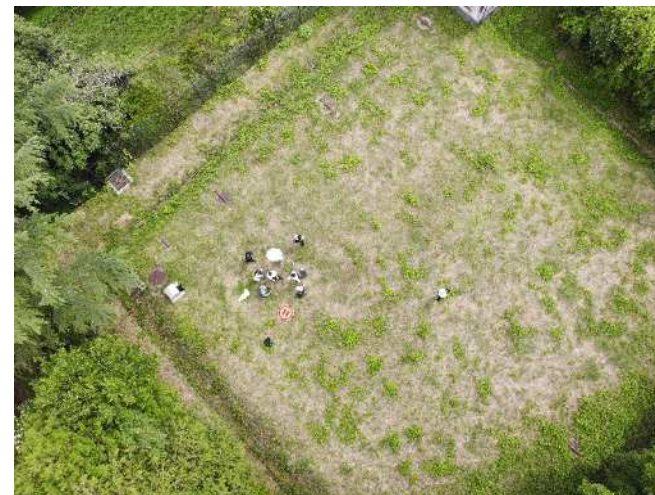
ドローンで撮影した佐助配水池
