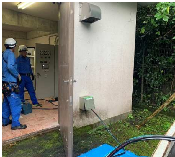
可搬型発電機に対応した設備
