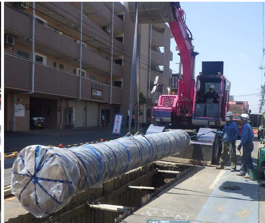
耐震継手管を布設している様子
