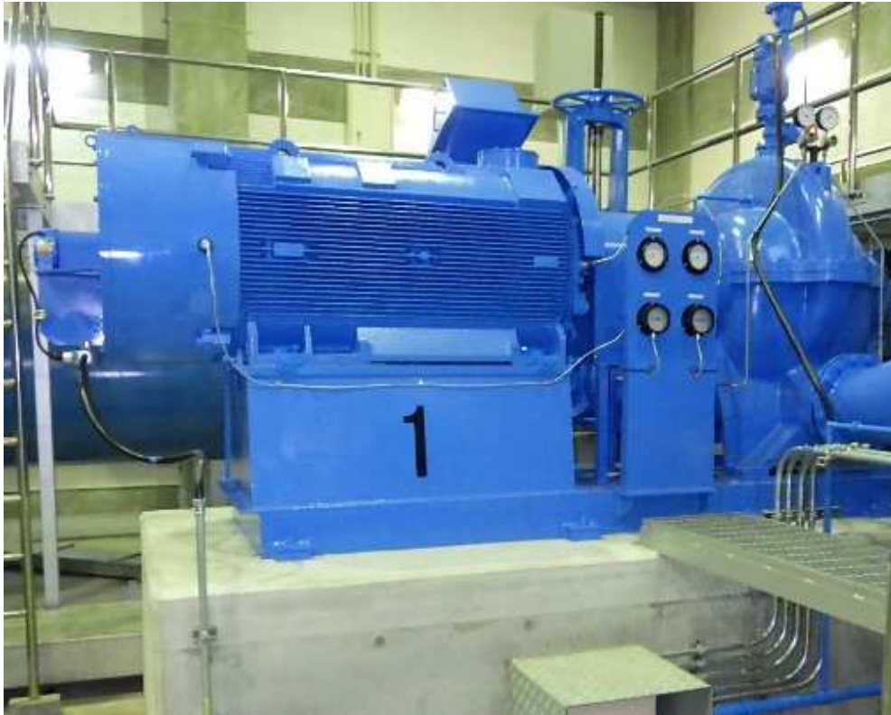
高効率設備(ポンプ)への更新 (淵野辺加圧ポンプ所)
