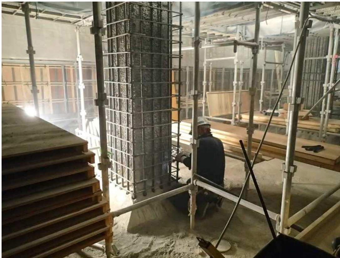
耐震性を向上させるため配水池内部の柱を太くしている様子
