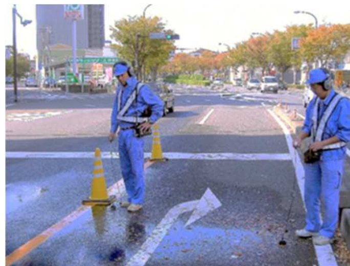
漏水個所を特定する様子
