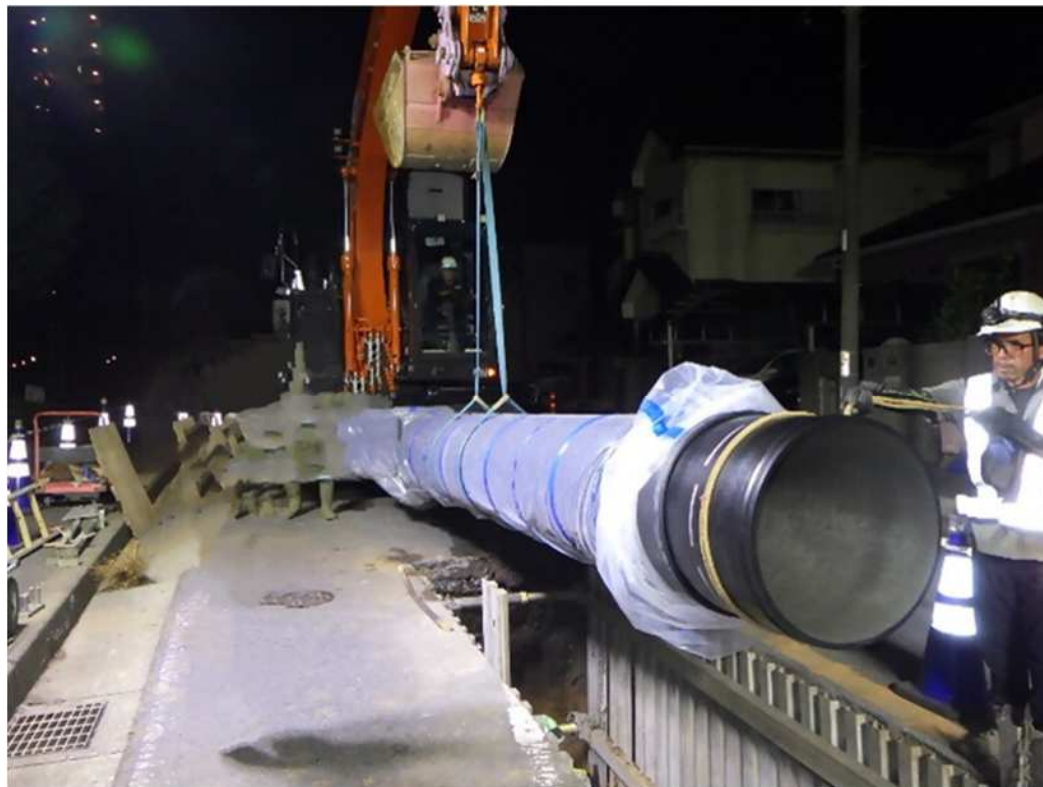
耐震継手管吊り下しの様子
