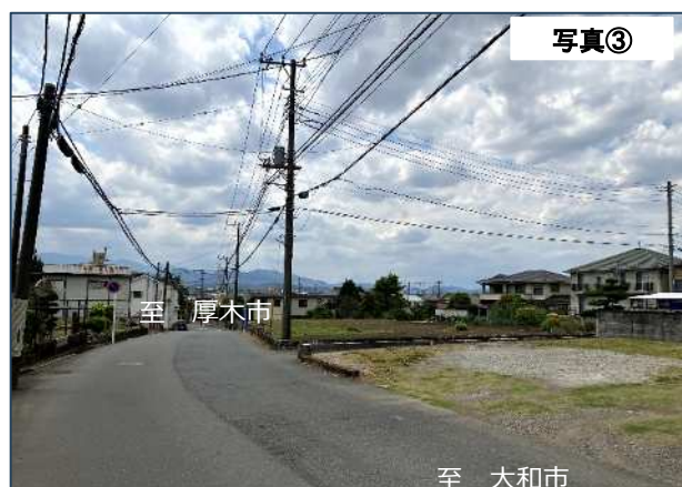
写真③ 用地買収箇所の状況（埋蔵文化財包蔵地）
