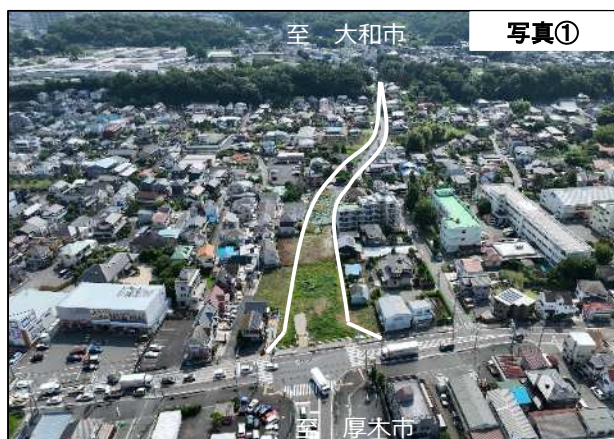
写真① 評価対象区間の状況（座間下宿交差点付近）
