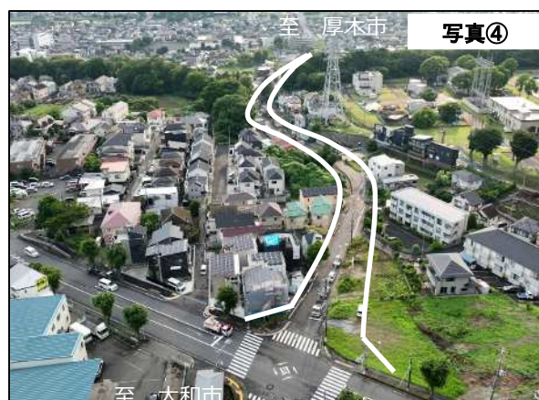
写真④ 評価対象区間の状況（県道51号町田厚木交差点付近）
