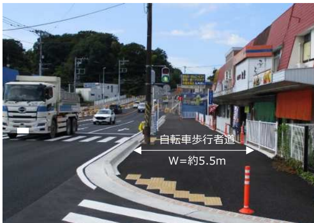
自転車歩行者道完成後の状況
