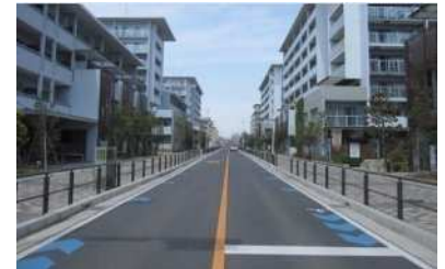
無電柱化（道路整備）
