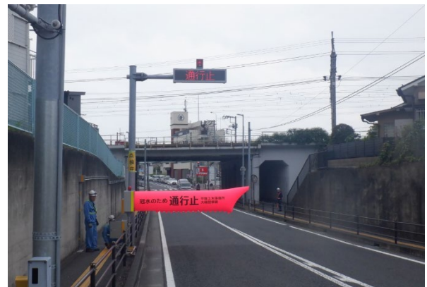
情報板及びエア遮断機の点検状況
