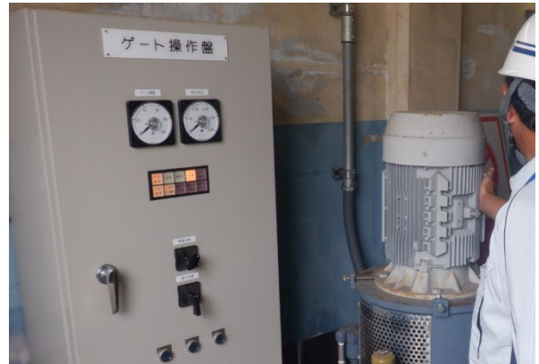
排水ポンプの点検状況
