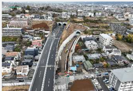
(都)城山多古線の整備(小田原市)
