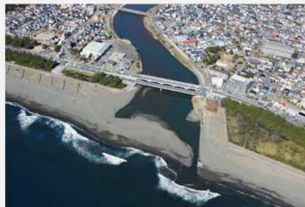
国道134号花水川橋の架替え(平塚市)
