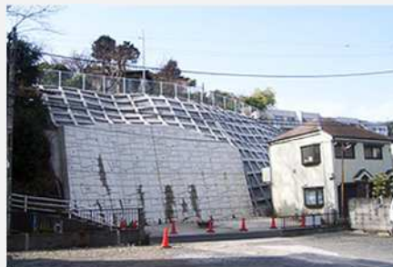
急傾斜地崩壊防止施設の整備(横浜市)
