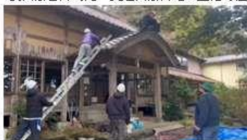
作業風景や作業現場
