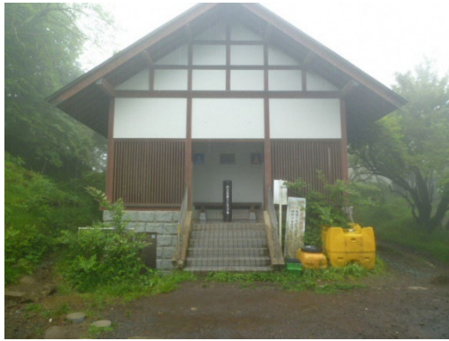
(40 年近く経過したトイレ)
