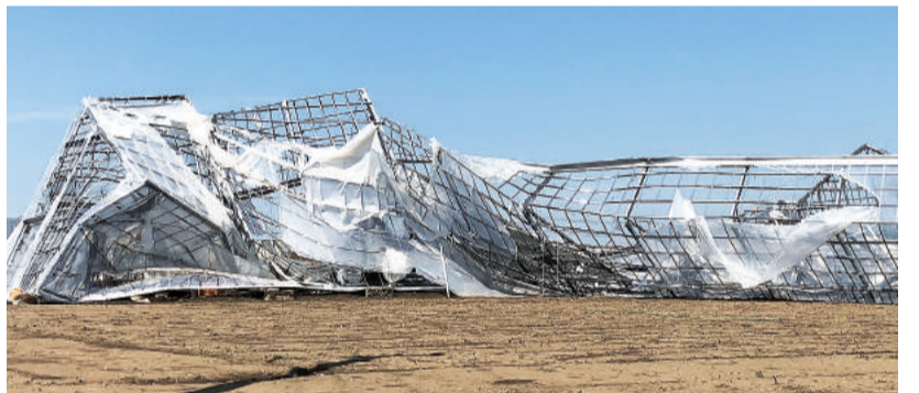
破損した 農業用ハウス (三浦市)
