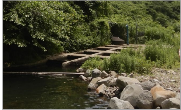
幕山浄水場の取水口
