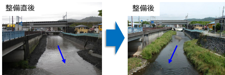
下流区間施工事例
