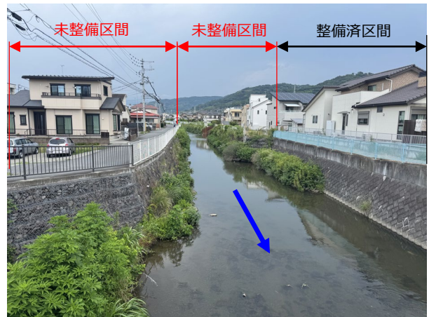
天神橋より上流方向
