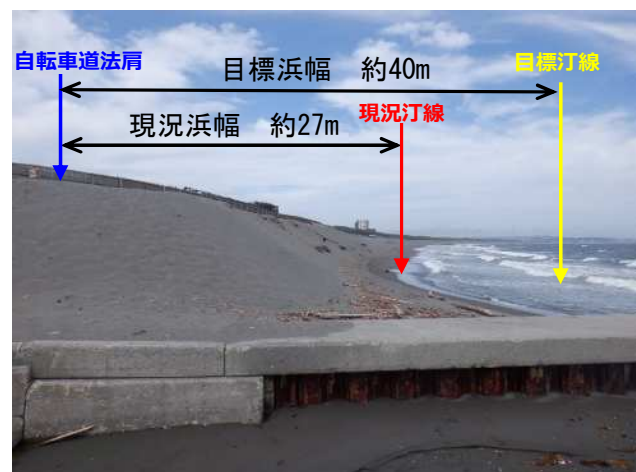
写真② 4号水路から東側を望む
