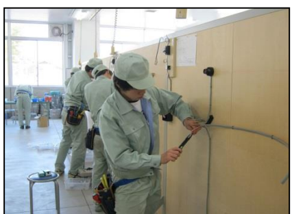
電気工事実習
