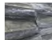
地層の食い違いである断層が多く見られます。You can also see many faults.
