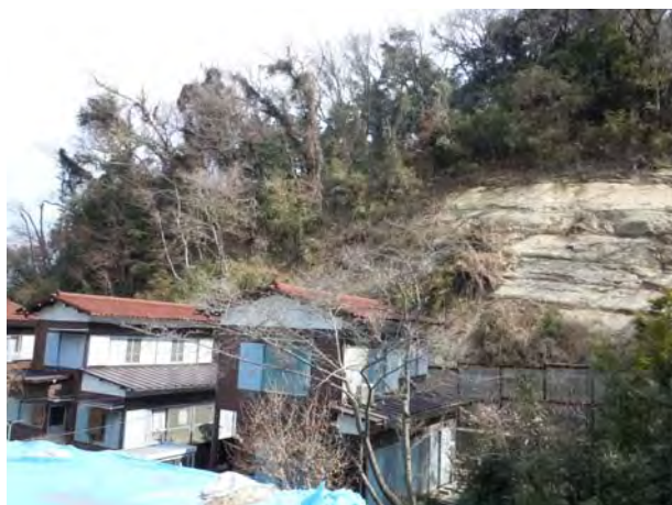
(浄明寺一丁目 土砂崩落状況)
