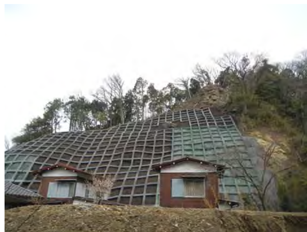
(同所 防災工事实施後)
