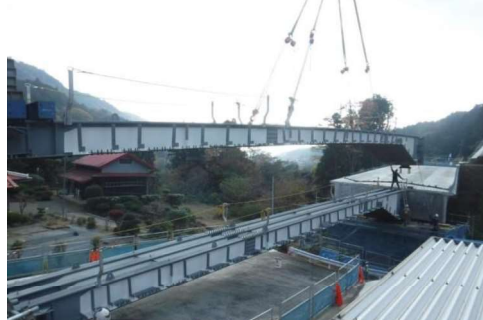
辺室沢橋の桁架設 (令和2年11月頃)
