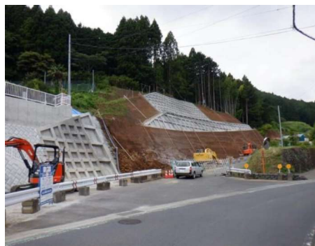
起点側交差点 (令和2年8月頃)
