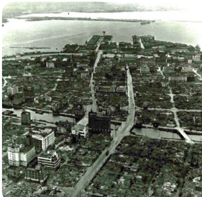
横浜大空襲による被害 (伊勢佐木町から馬車道周辺の焼けあと) ※米国国立公文書館所蔵 横浜市史料室提供
