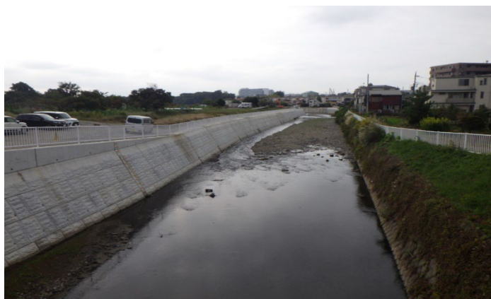
護岸整備工事（引地川（藤沢市内））
