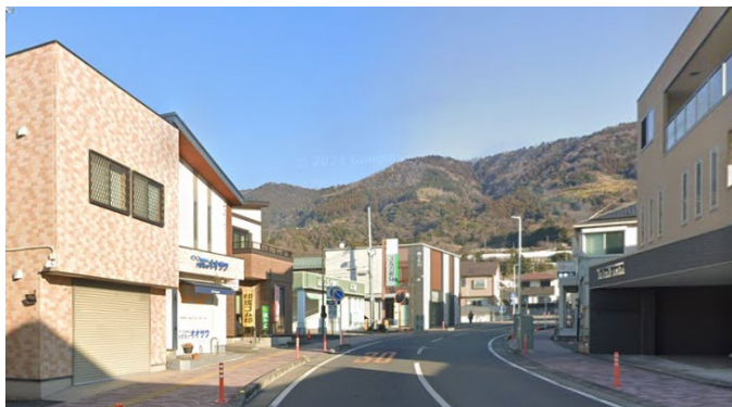
電線地中化工事（松田町内）
