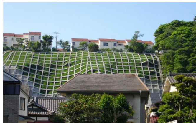
急傾斜地崩壊対策（横浜市中区内）
