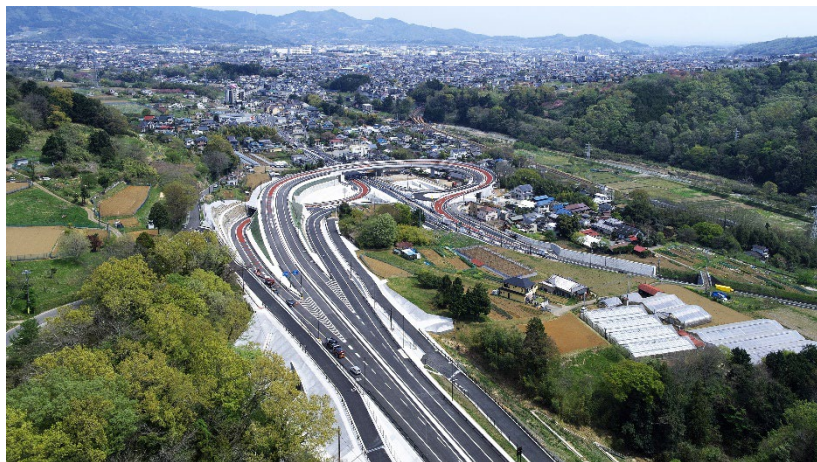
新秦野インターチェンジへの接続道路
