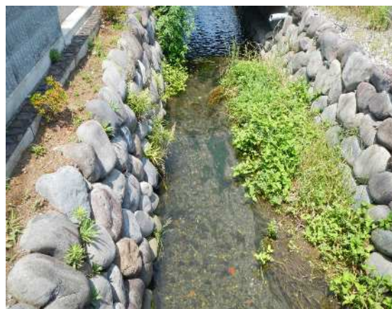
伏流水や湧水を遮断しない護岸整備により 生きものに配慮した川づくり （小田原市堀之内）
