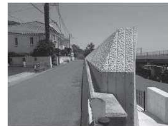
護岸嵩上げによる整備状況
