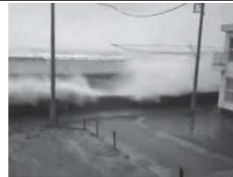
台風時における整備前の越波状況
