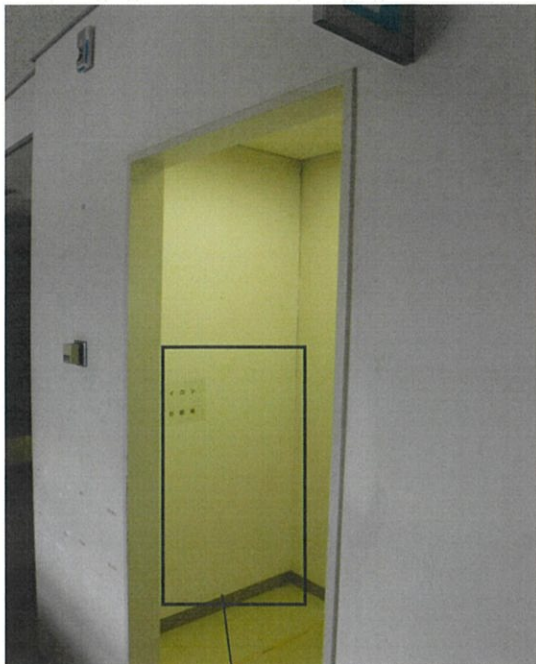
写真1 給湯室の製氷機+架台設置側
