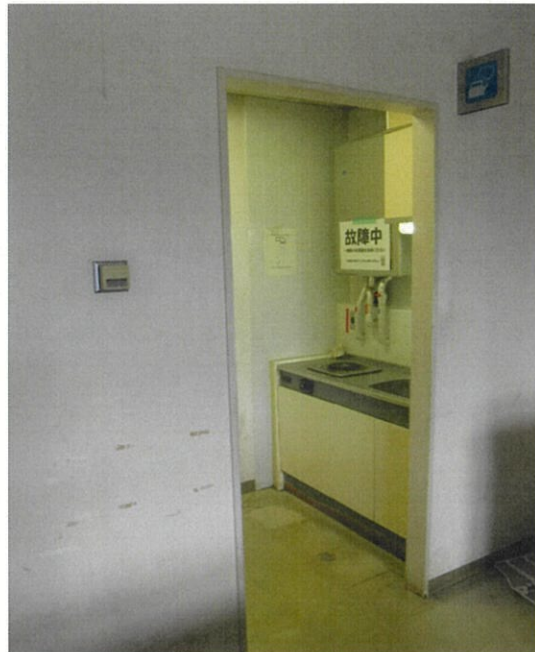
写真2 給湯室の流し台給湯ユニット
