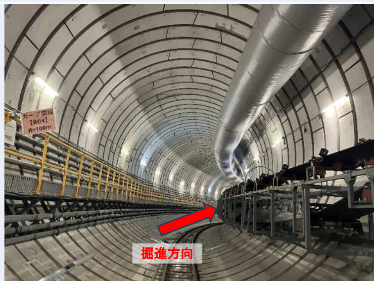
トンネル坑内(発進立坑から950m地点)
