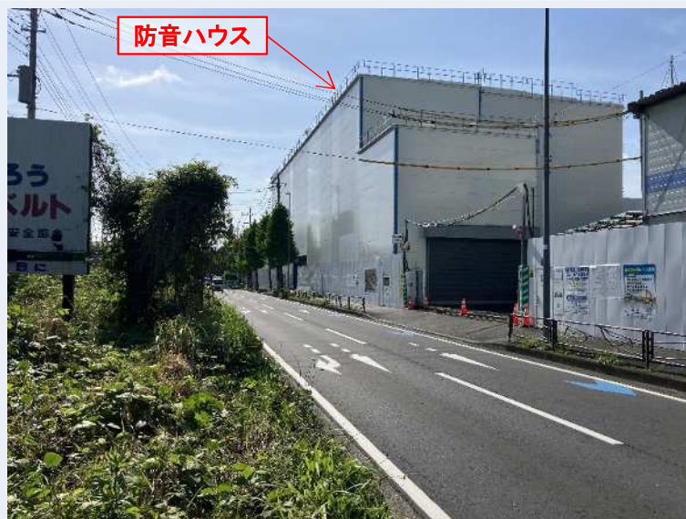
工事ヤード(防音ハウス)全景
