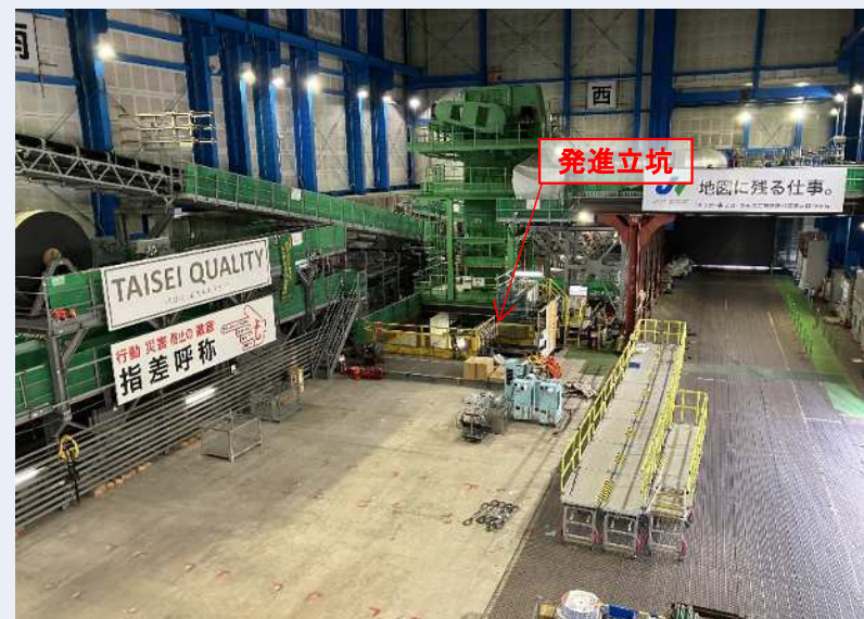
防音ハウス内部(発進立坑)
