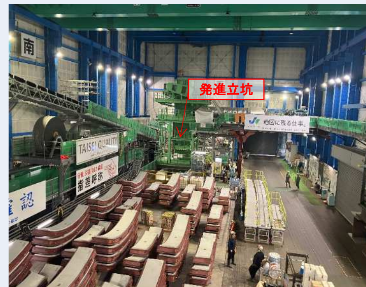
防音ハウス内部(発進立坑)
