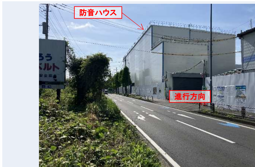
工事ヤード(防音ハウス)全景
