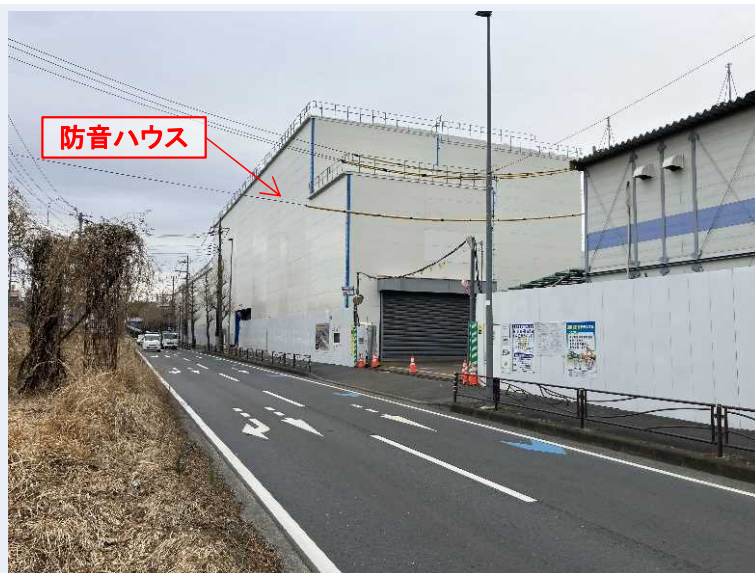
工事ヤード(防音ハウス)全景
