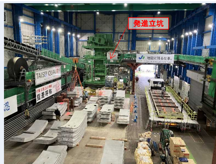
防音ハウス内部(発進立坑)
