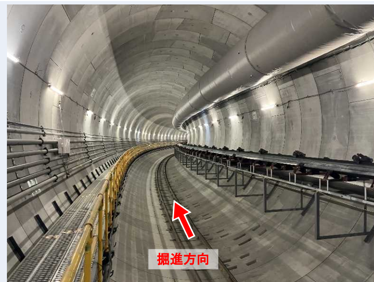
トンネル坑内(発進立坑から450m地点)
