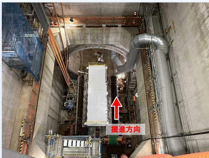
操作設備等入れ替え作業(発進立坑内)
