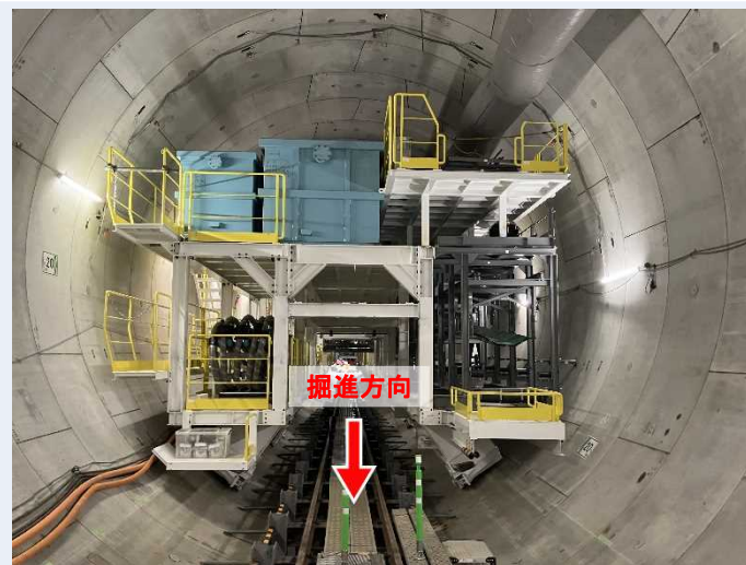
操作設備等入れ替え作業(トンネル坑内)
