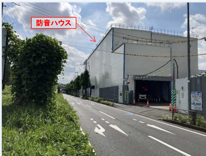
工事ヤード(防音ハウス)全景
