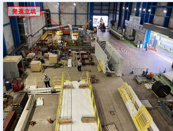
防音ハウス内部
