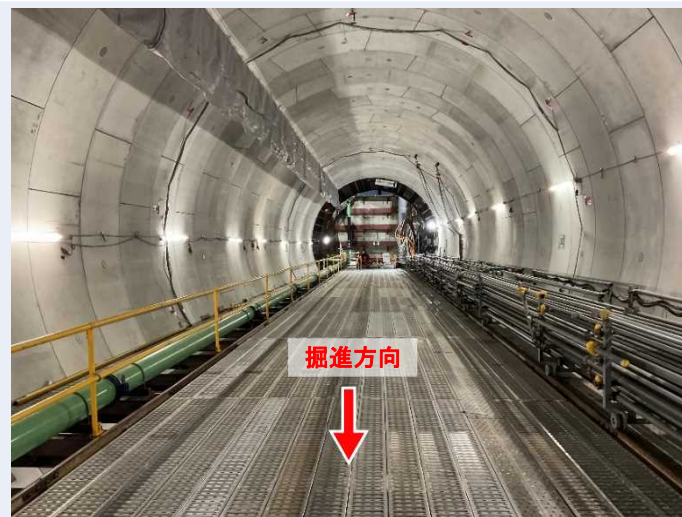
トンネル坑内(発進立坑から約100m地点)
