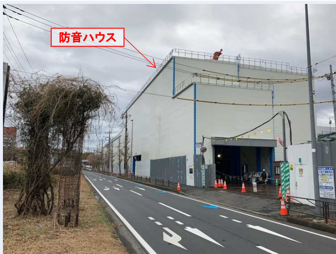
工事ヤード(防音ハウス)全景
