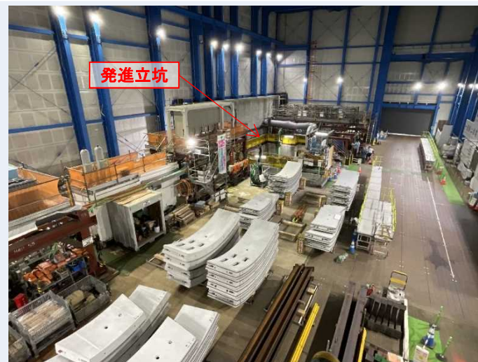
防音ハウス内部
