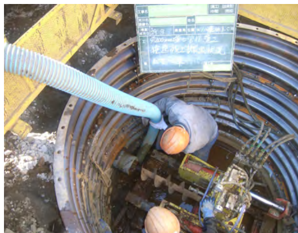
公共下水道の整備（相模原市）
