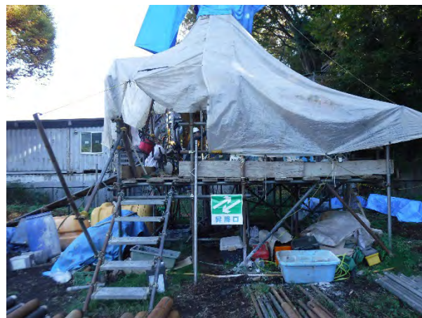
水理構造調査ボーリング（秦野市）
