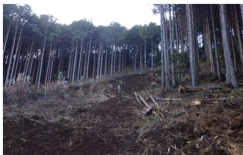
水源林の基盤の整備
