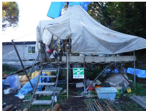
水理構造調査ボーリング（秦野市）
