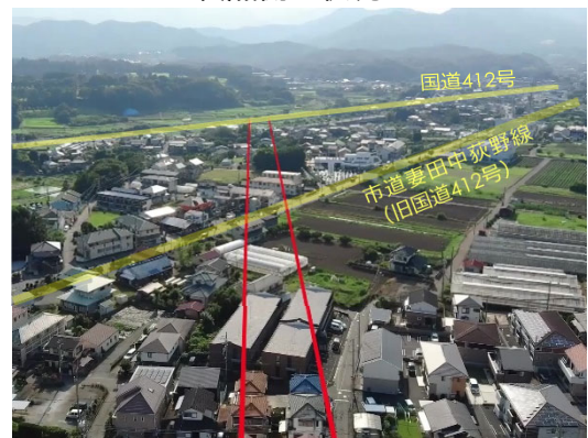
終点側の状況
