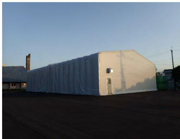
神奈川県管理の備蓄倉庫
