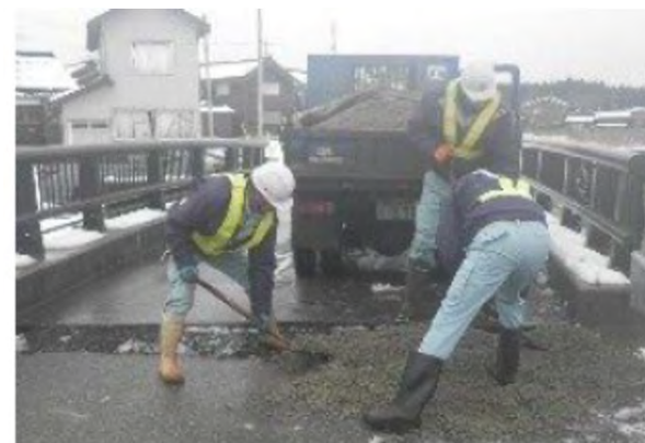
道路の段差解消作業
