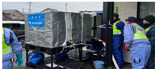
能登半島地震支援(仮設受水槽)
