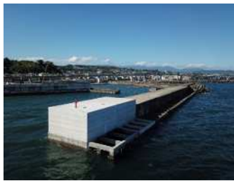
防波堤の延伸工事（小田原漁港）
