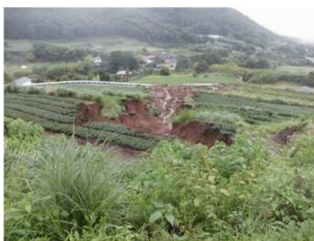
農地の被災状況（秦野市）
