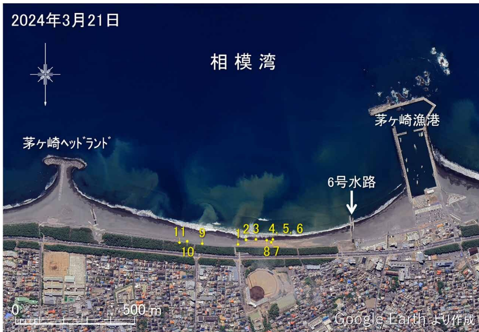
図-1 茅ヶ崎中海岸の衛星画像と写真撮影地点 (St.1～St.11)
