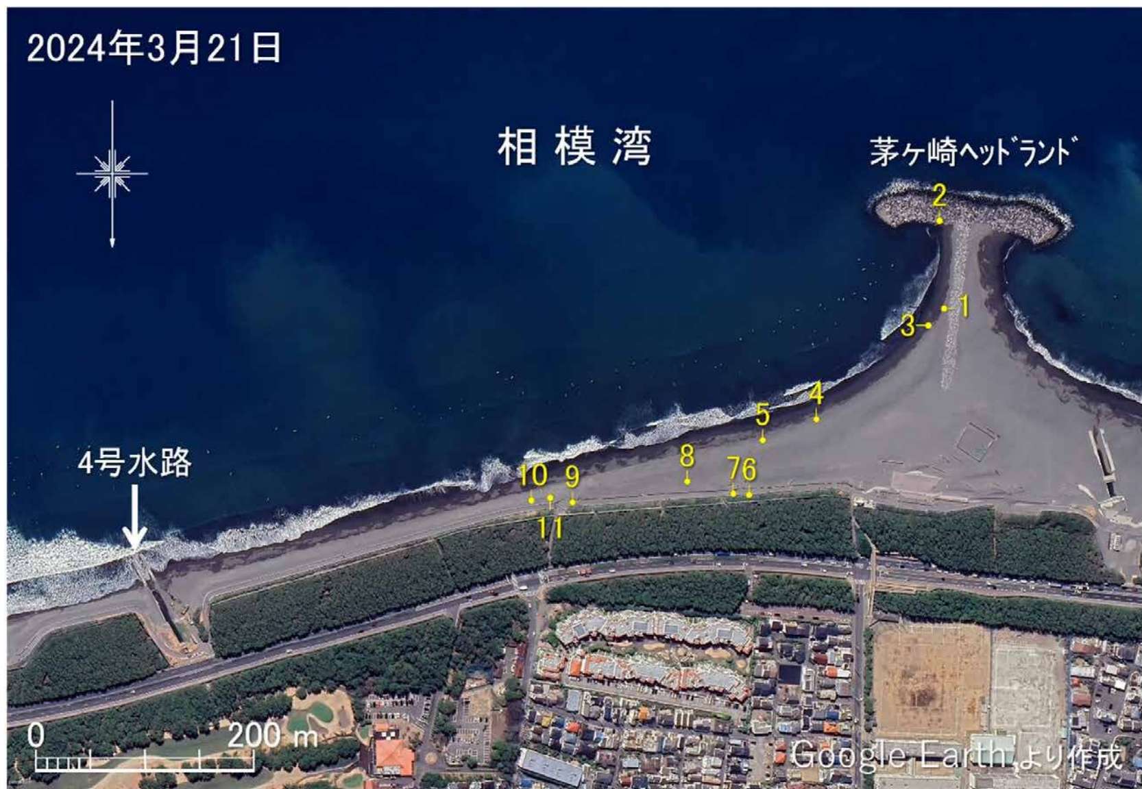
図-1 菱沼海岸の衛星画像と写真撮影地点 (St.1～St.11)
