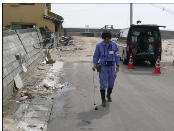
図—3 災害時の現場調査
