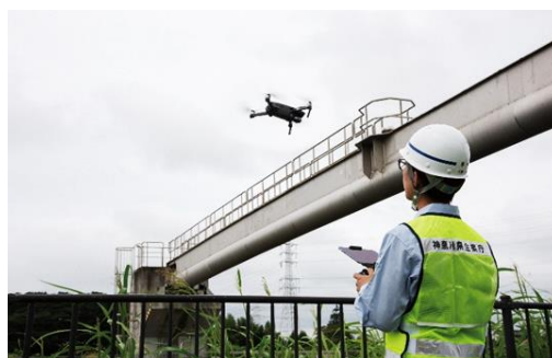
【図6】ドローンによる点検
