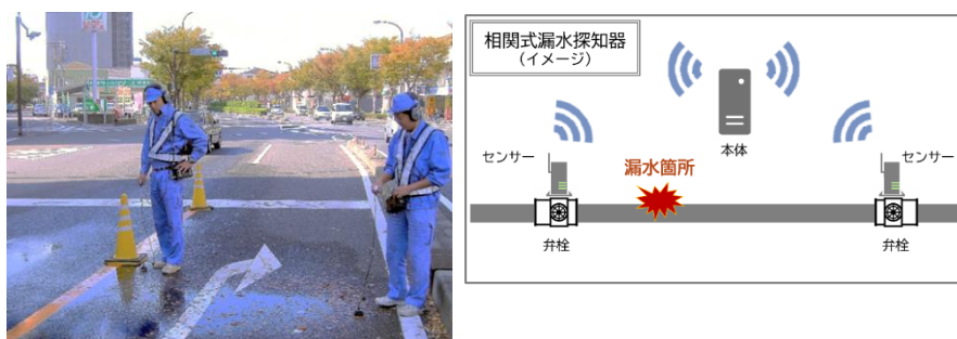
【図 10】 漏水調査の様子
