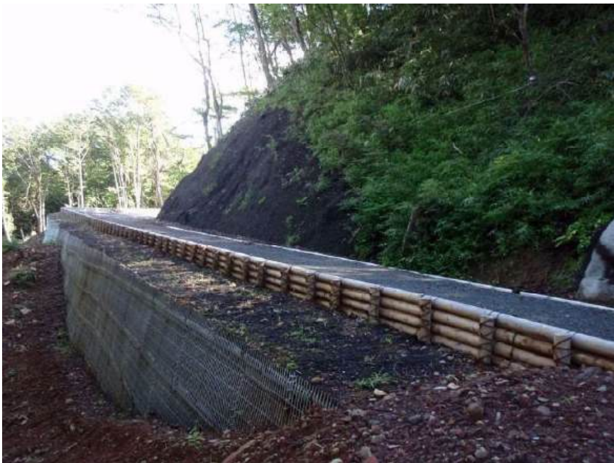
補強土壁工 H24 施工(起点から 9.5 km).
