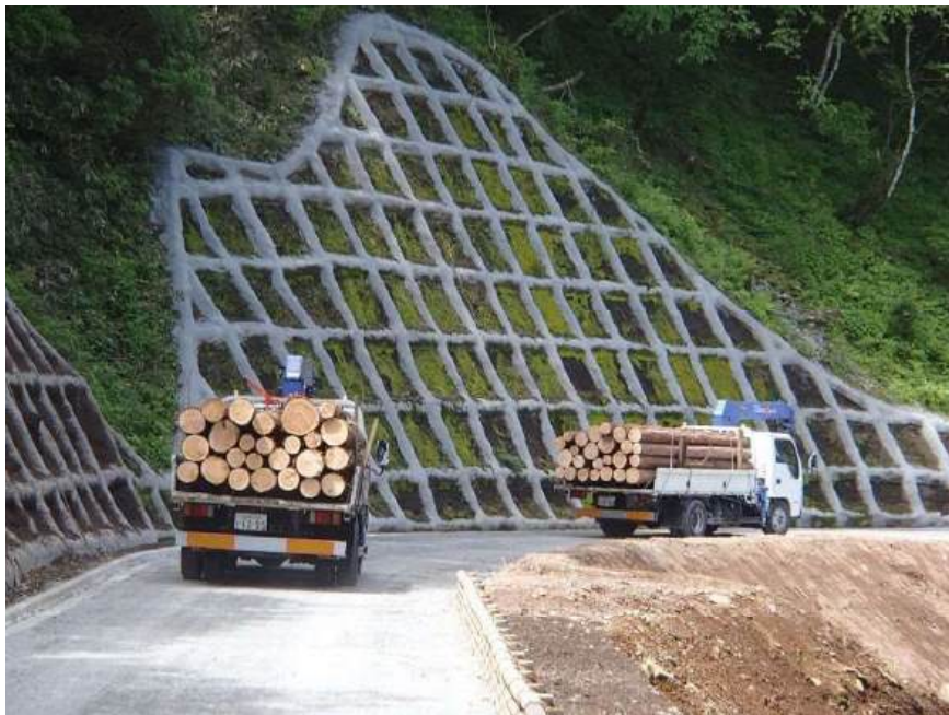
水源林 間伐材搬出状況
