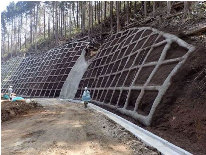
簡易法枠工 H30 施工(起点から 8.0 km).
