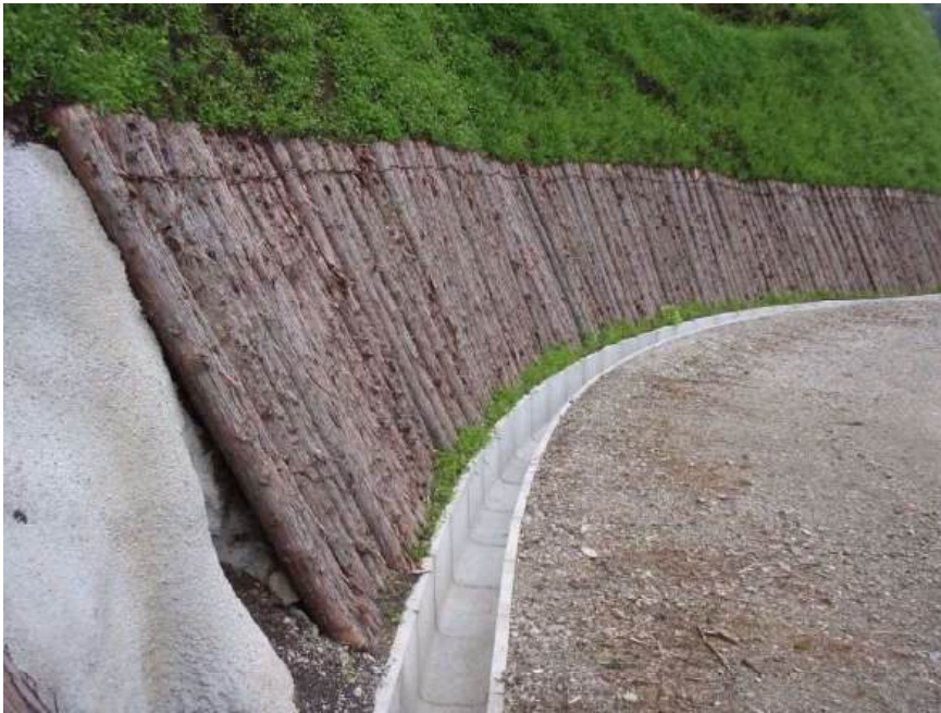
丸太伏工 H20 施工(起点から 6.5 km).
