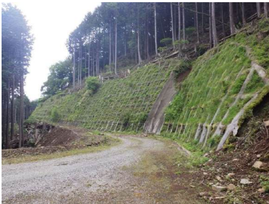
簡易法枠工 R6 植生回復状況(起点から 8.0 km).
