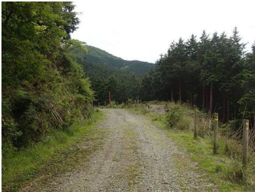
視線誘導工 H20 施工(起点から 6.5 km).
