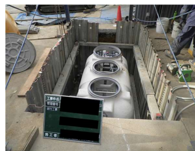
一般家庭への浄化槽設置（相模原市）
