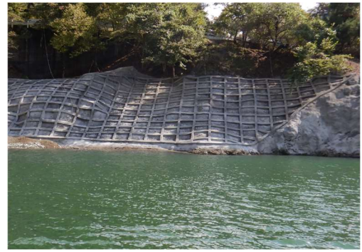
丹沢湖周辺崩落防止工事
