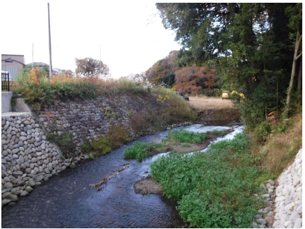
生態系に配慮した水路整備工事 (相模原市道保川)
