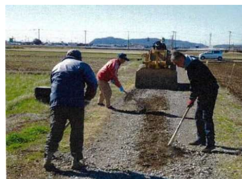
農道の軽微な補修 (多面的機能支払事業)
