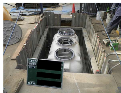
一般家庭への浄化槽設置（相模原市）
