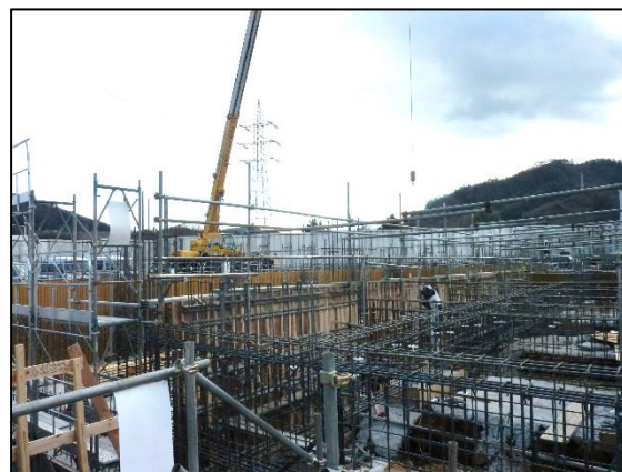
図―６ ポンプ所の建設
