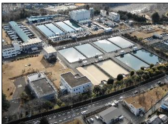
図―５ 浄水場の再整備
