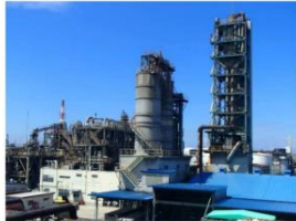
BPAプラント（三井化学 大阪工場）
