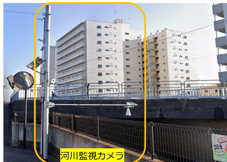
河川監視カメラ設置状況
